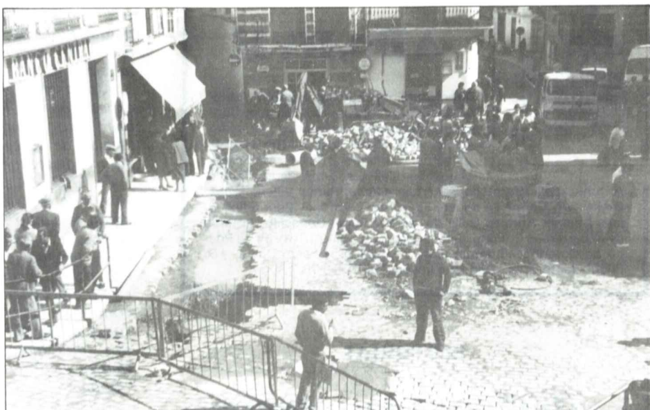
Las obras de reposición de la red de saneamiento llegaron de nuevo a la plaza
