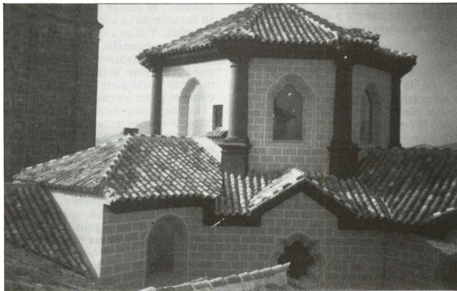
El exterior del Sagrario después de la restauración
