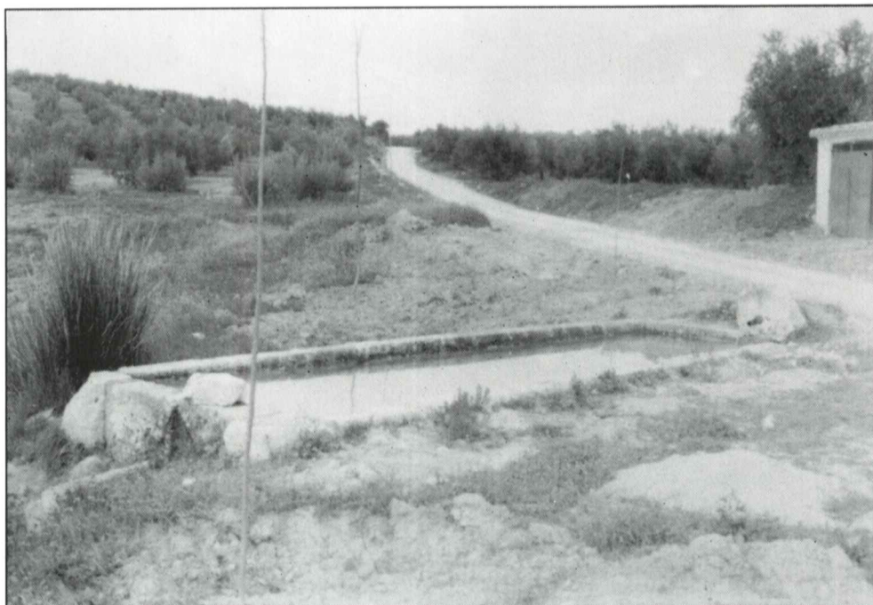
Abrevadero del “Pozo del Rey” en plena Dehesa de Castil de Campos. Hace unos días que acaba de recuperar el aspecto que presenta en la fotografía, pues a pesar de las lluvias permanecía seco debido a la obstrucción del manantial del que se surte.
