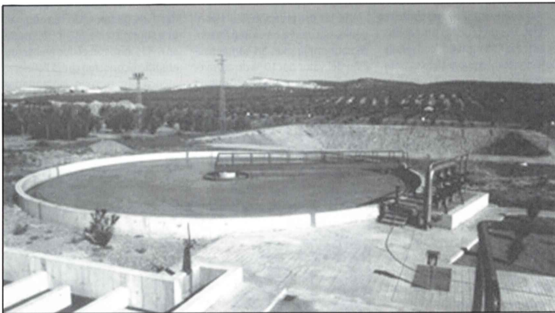
Depuradora de Bailén.
