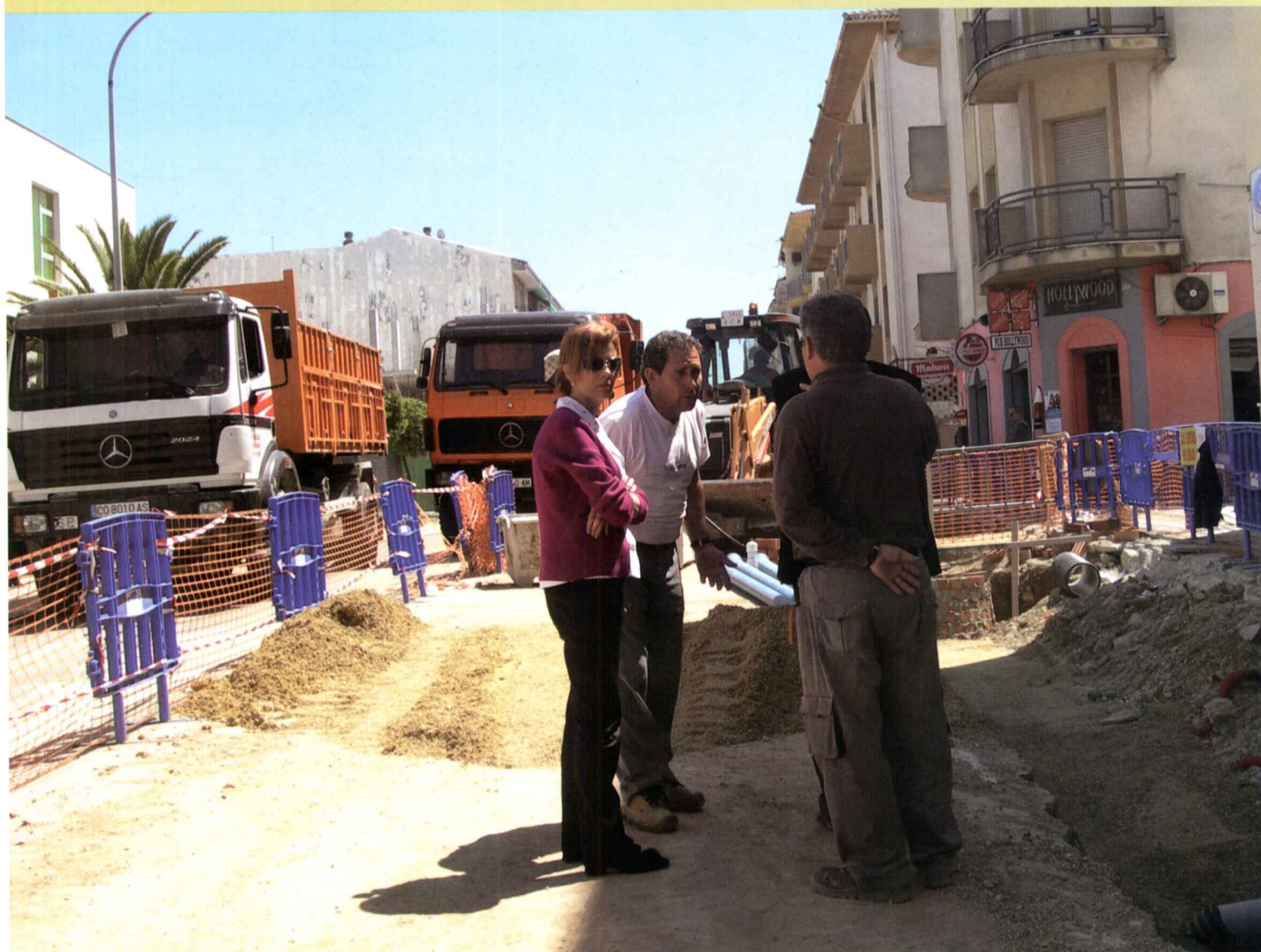
La alcaldesa Encarnación Ortiz durante su visita a las obras de la avenida de España
