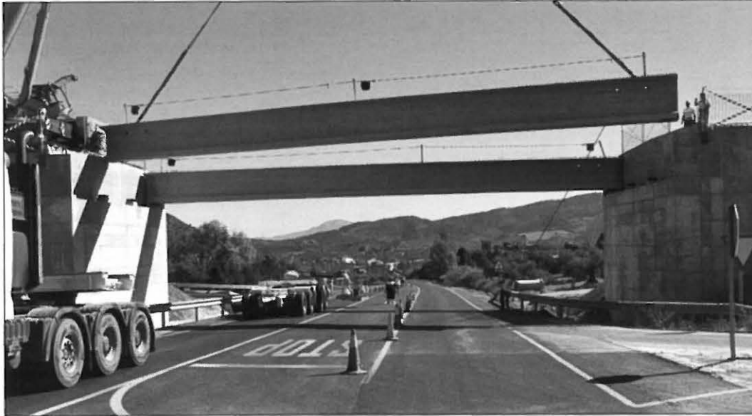
Colocación del paso elevado
