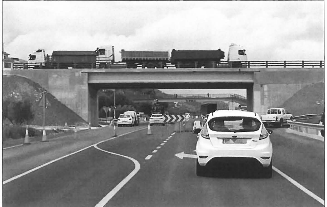
Realizando las tareas de prueba de carga sobre el puente
