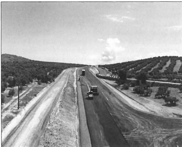
Vista del tramo asfaltado
