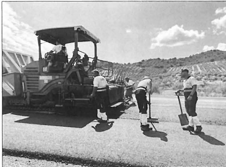
Operarios en tareas de asfaltado
