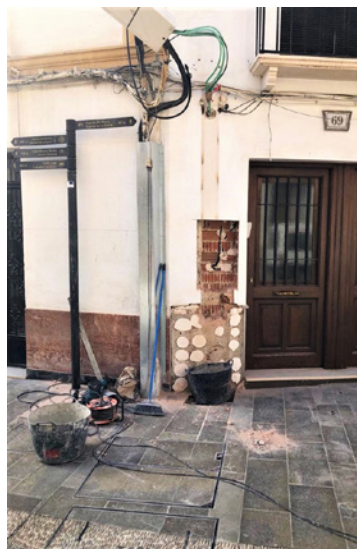
Intervención en una de las fachadas de la Calle Río
