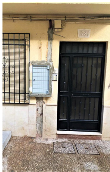
Intervención en una de las fachadas próximas a la F. del Rey
