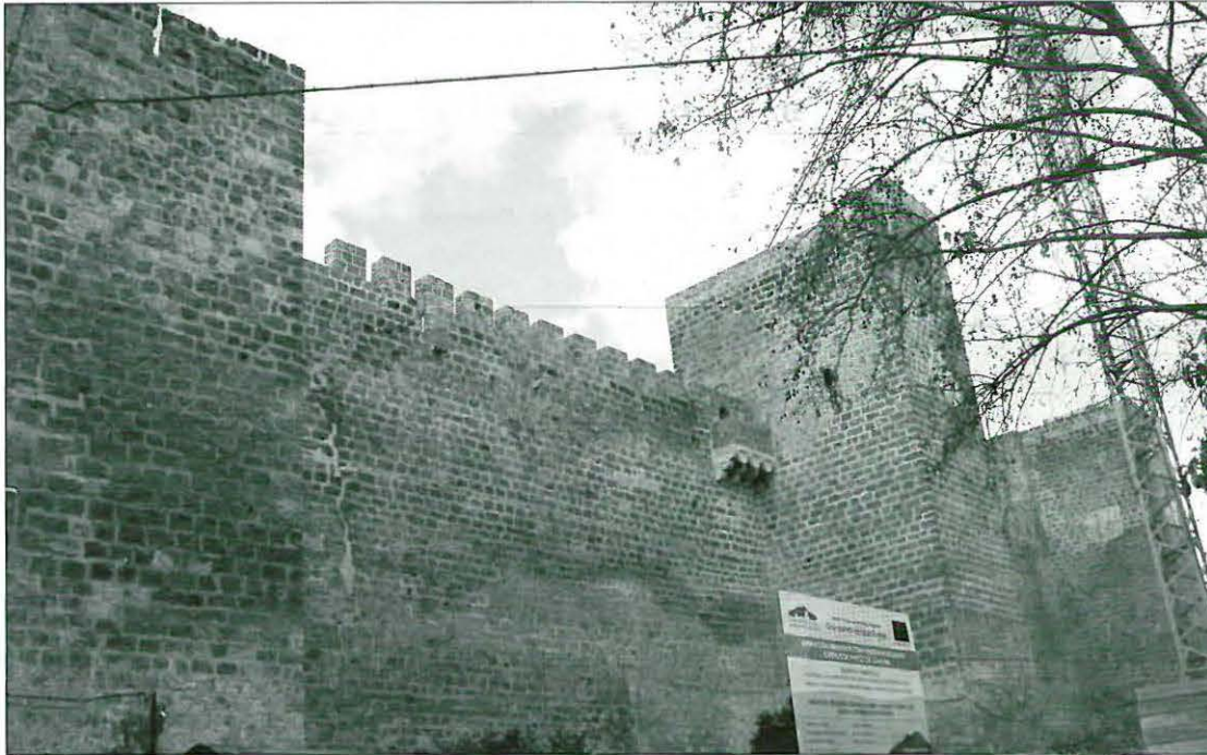
Última restauración de parte de la fachada principal
