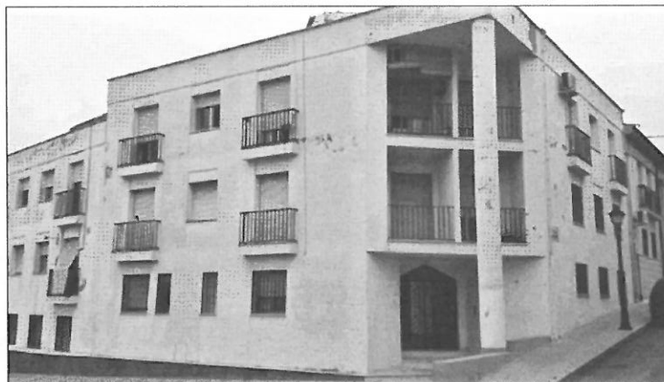
Viviendas públicas en la Avenida de Granada donde se está interviniendo
