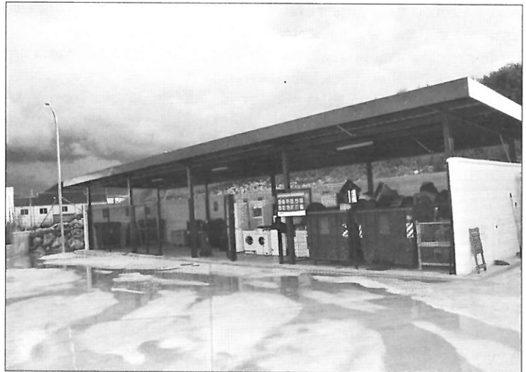
Dependencias de clasificación en el interior del Punto Limpio
