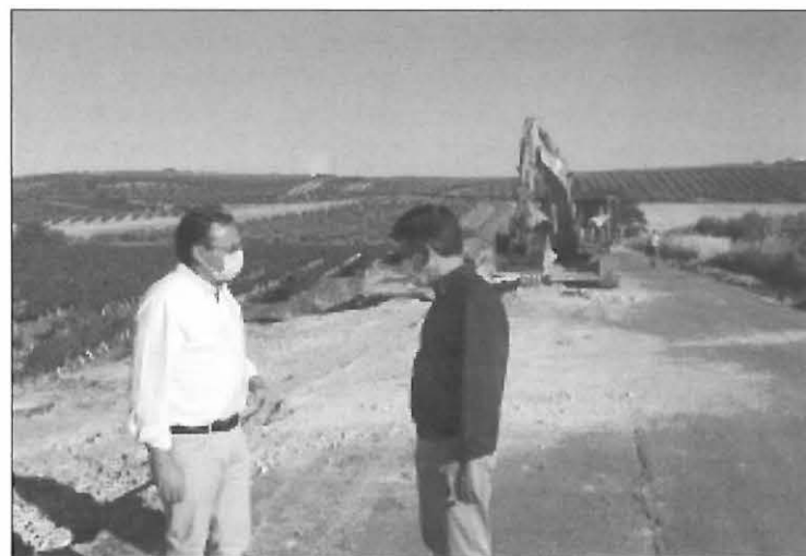
Palomares visitando las obras
