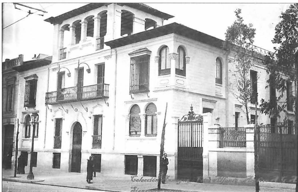
Residencia de Alcalá-Zamora en Madrid antes de su demolición
