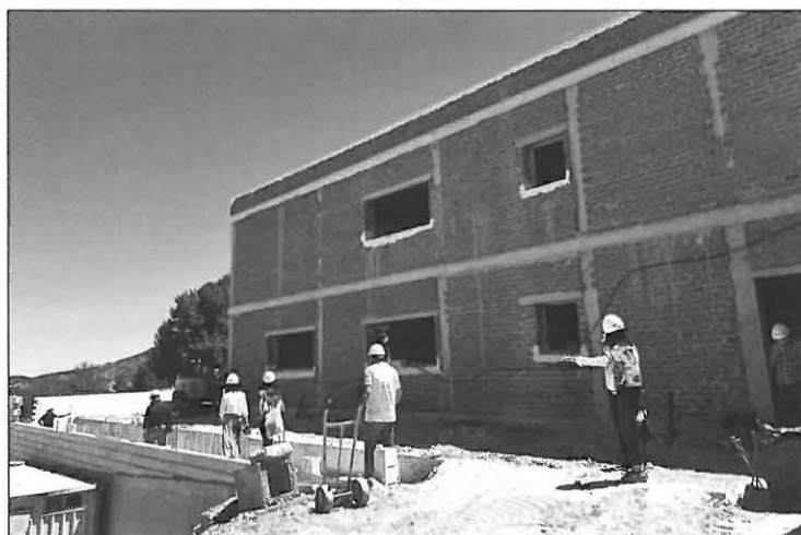
Estado de las obras
