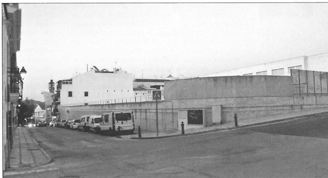
Bajos del colegio Carmen Panti3n destinados a los aparcamientos municipales
