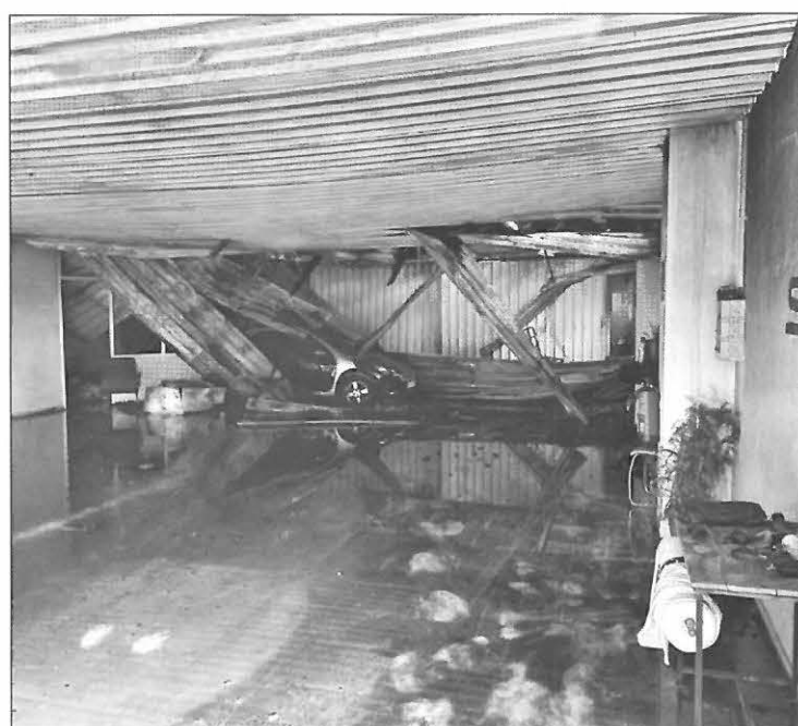
Interior de la nave de exposición
