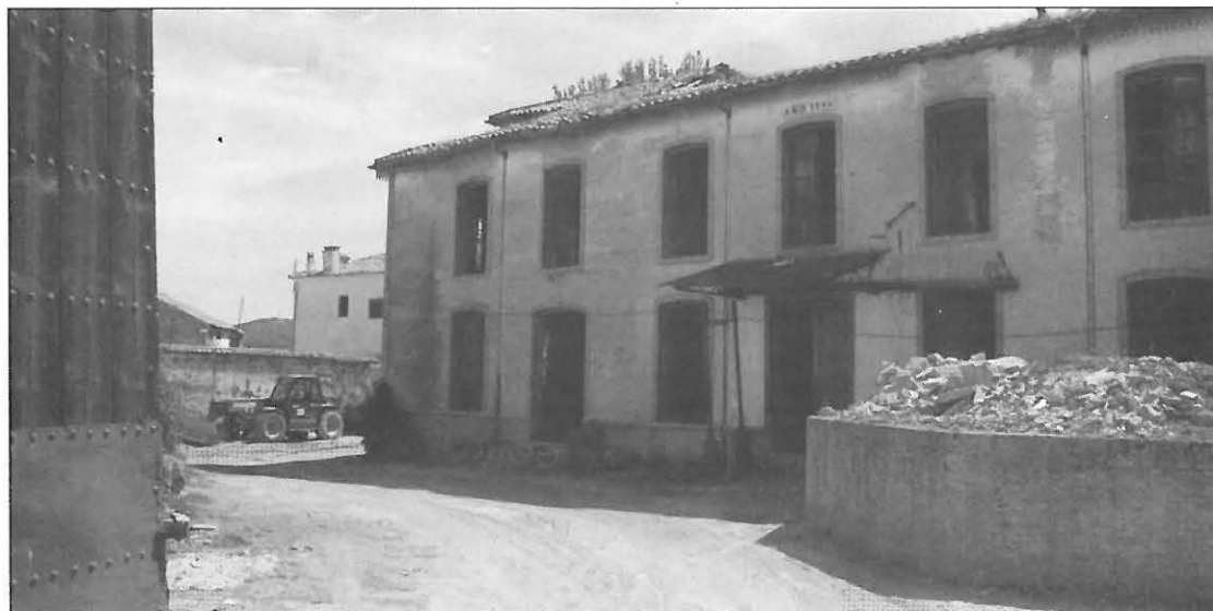
Estado actual del edificio
