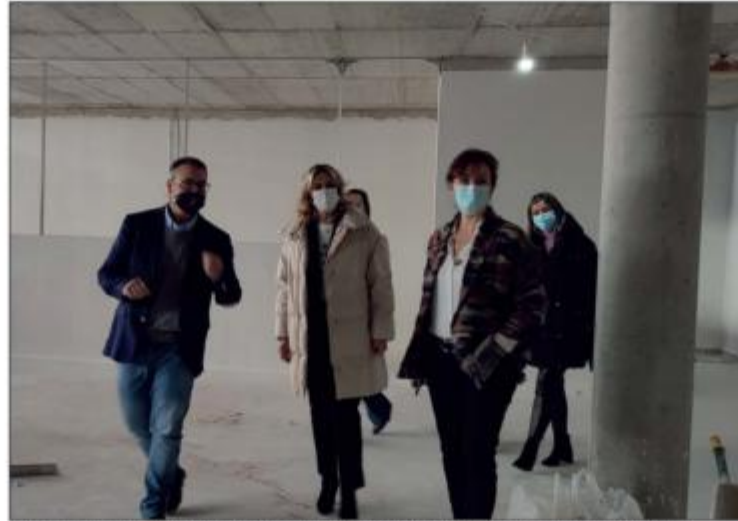
Inmaculada Troncoso visitando las obras del IES Carmen Pantión
