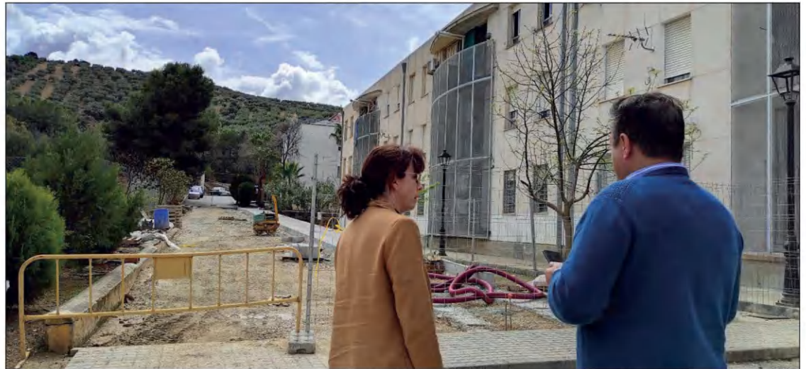
La alcaldesa, María Luisa Ceballos, y el concejal de Obras, Javier Ibáñez, visitando el lugar de las obras
