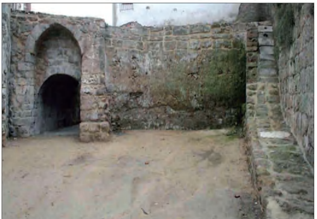
La Puente Llovía tras su limpieza en 2005
