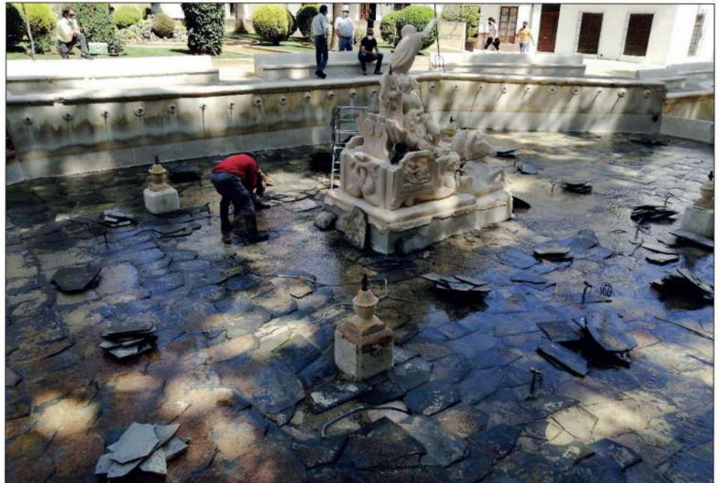
Retirando las losas de pizarra del suelo
