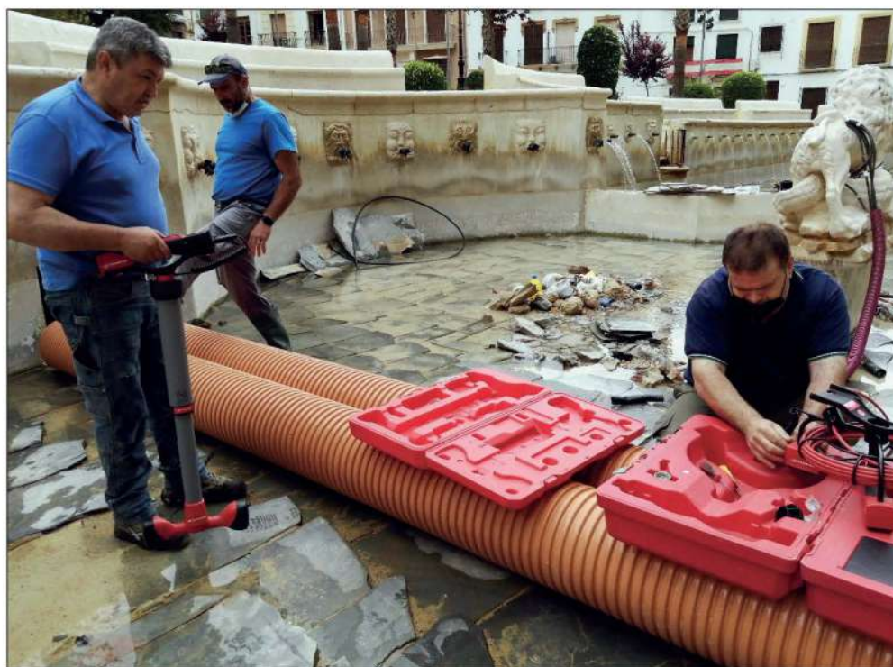
Varios operarios colocan los cables para la iluminación
