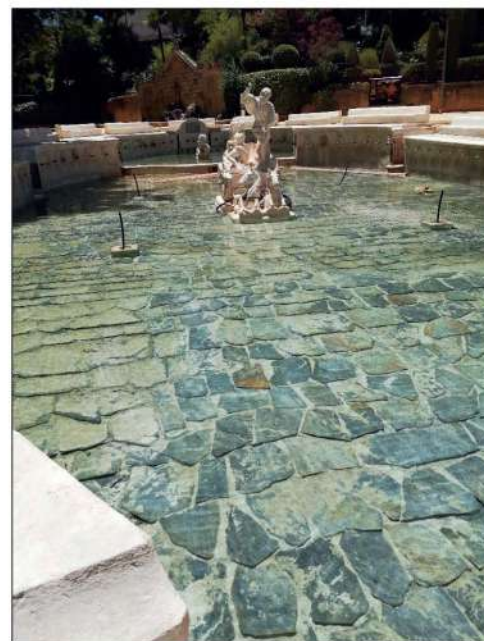
Aspecto del suelo al finalizar los trabajos
