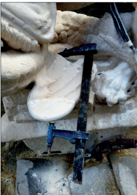
Trabajos de restauración
