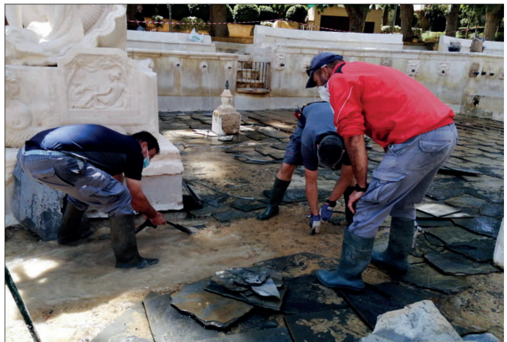
Retirada de losas para cubrir los cables
