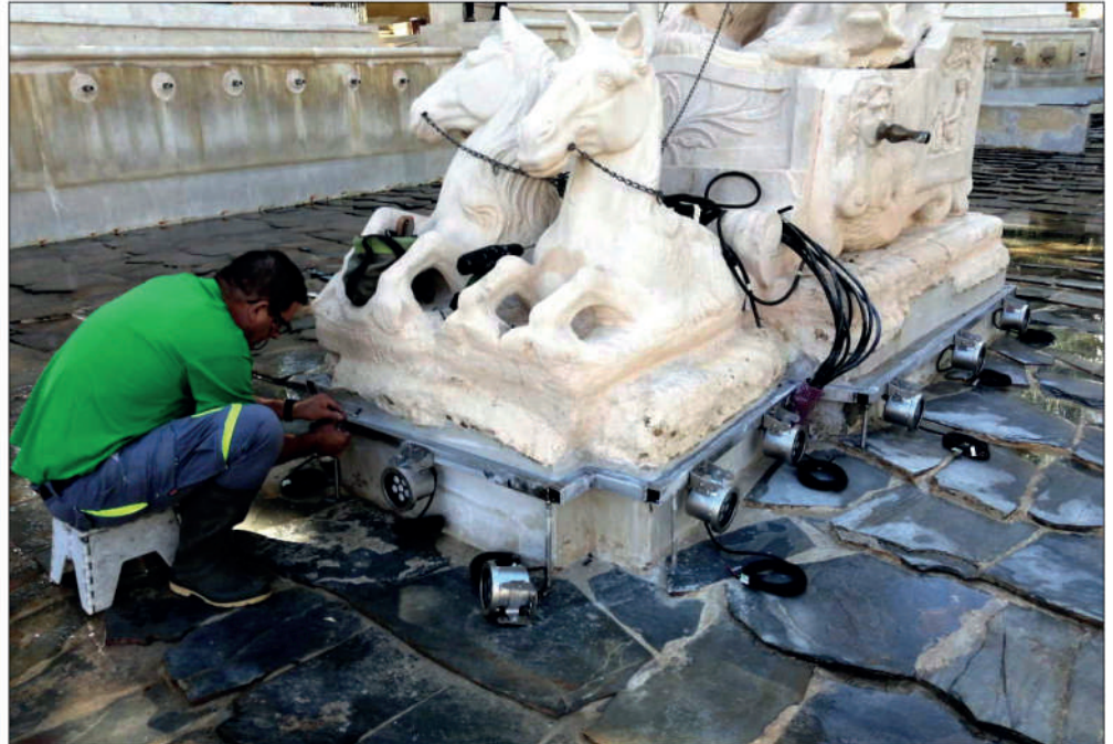
Instalación de los focos entorno a la imagen de Neptuno
