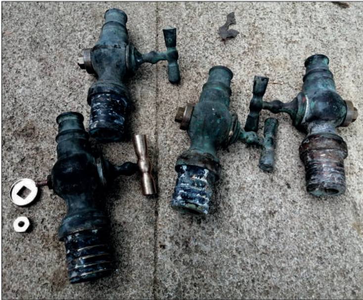
Grifos desmontados para su restauración
