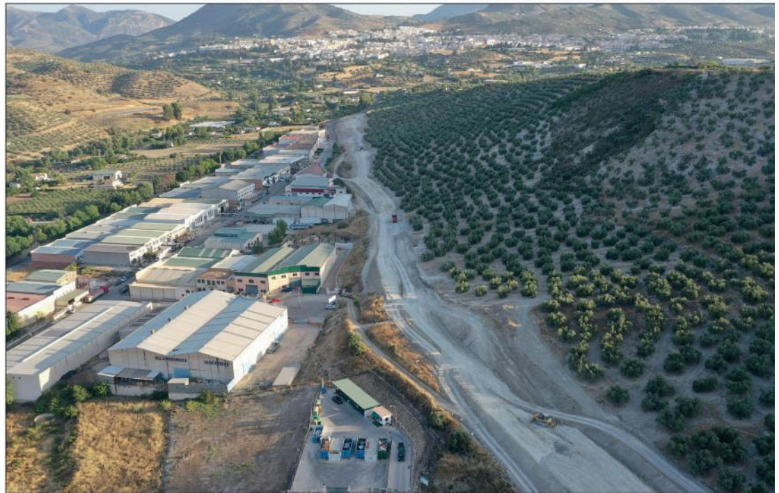
Vista aérea de las obras
