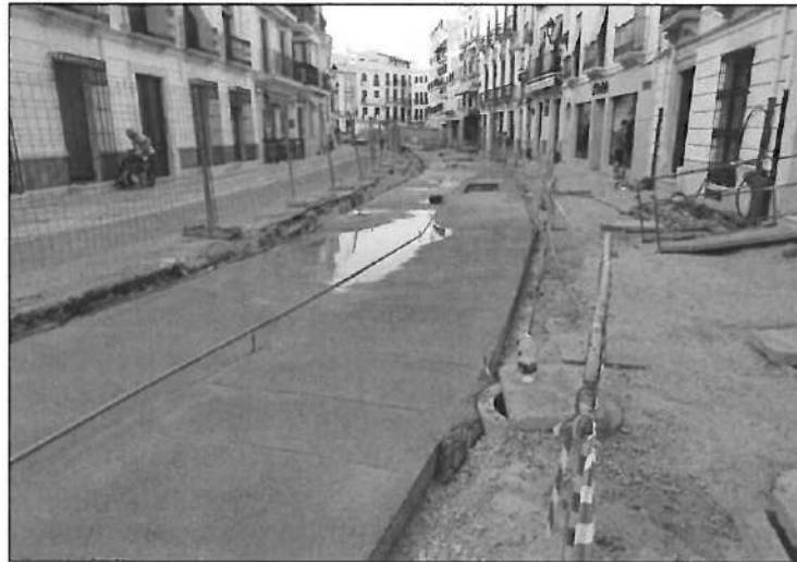
Estado de las obras
