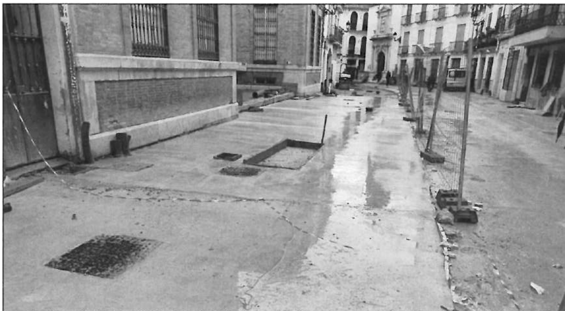
Estado actual de las obras
