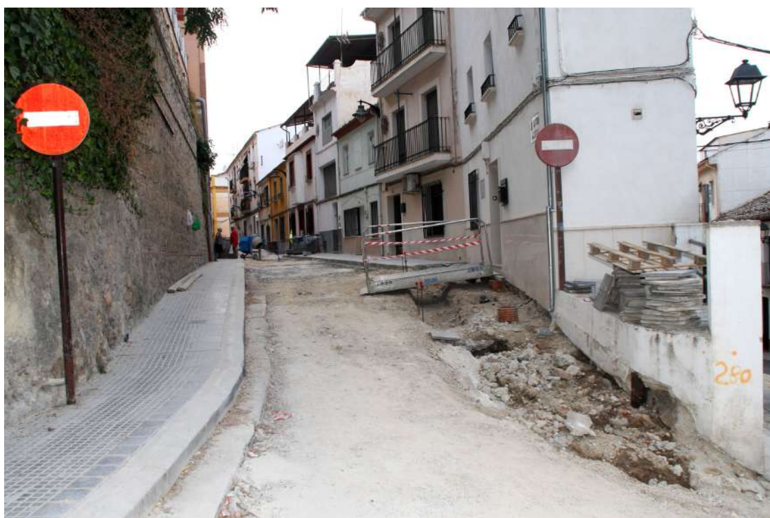
Obras en calle San Pedro Alcántara.
