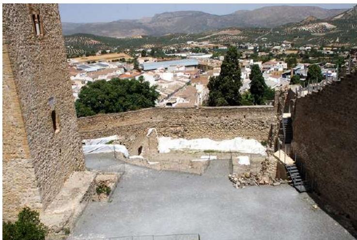
Frontal principal de la muralla a intervenir.
