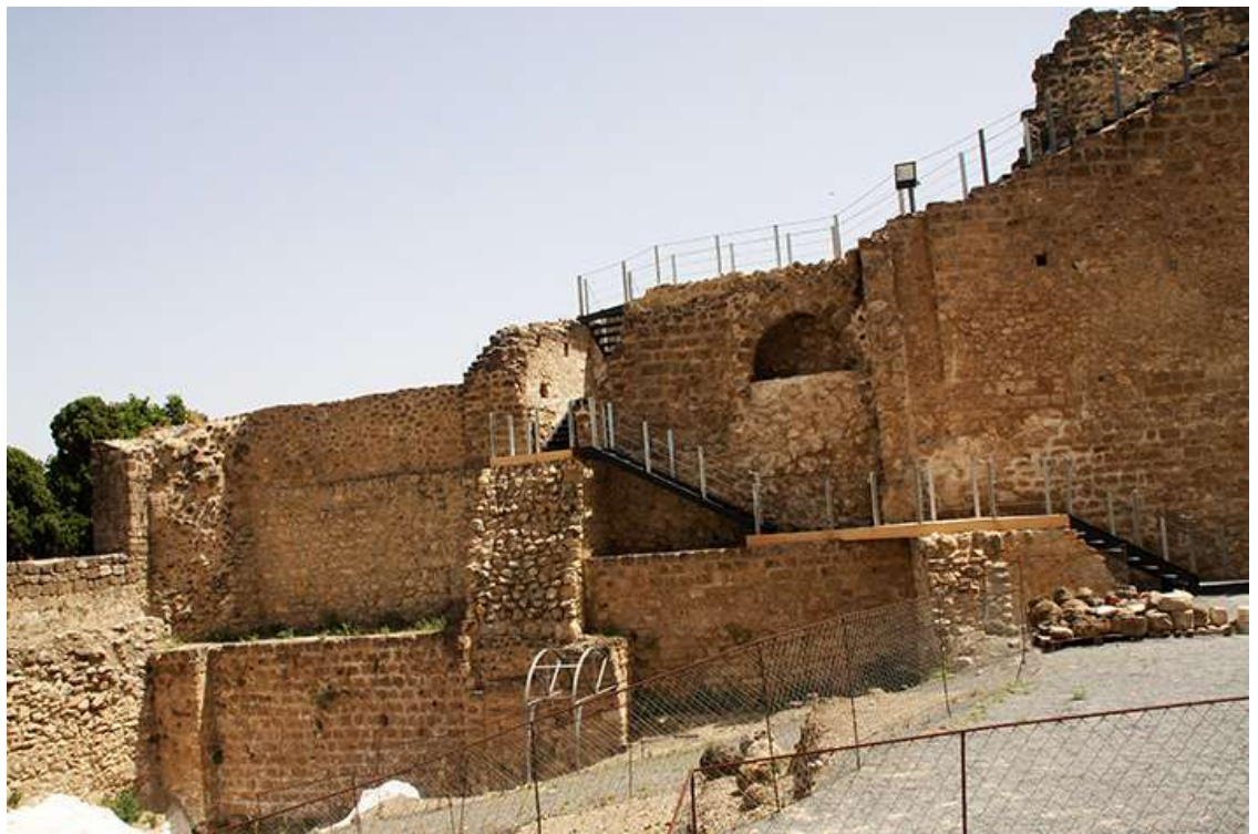
Final de la muralla a intervenir junta a escalera de acceso a las torres centrales del castillo.
